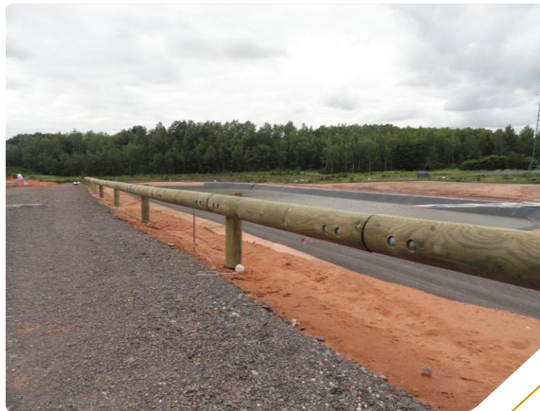
Aménagement de friches industrielles en zone tertiaire
