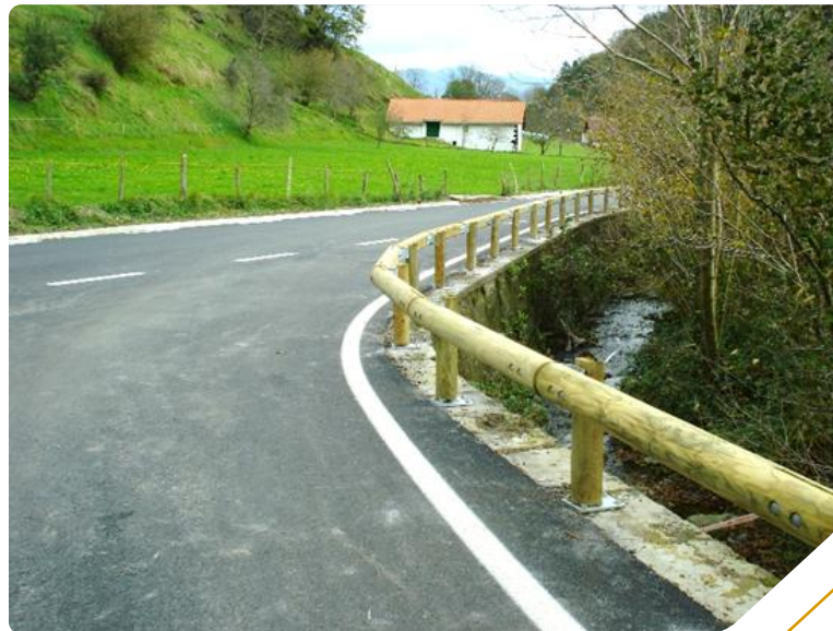
Route départementale – S42 sur longrine béton
