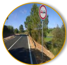
Strade con forte pendenza
