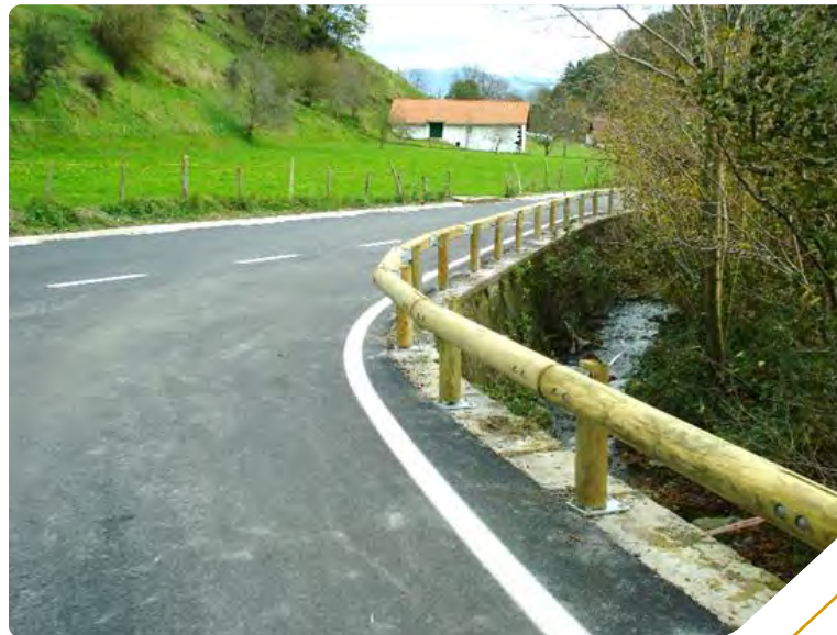
Strada provinciale – S42 su travi longitudinali in calcestruzzo
