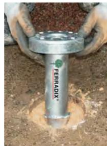
Pieux d'ancrage **CITY** Adjonction de 20 % de béton
