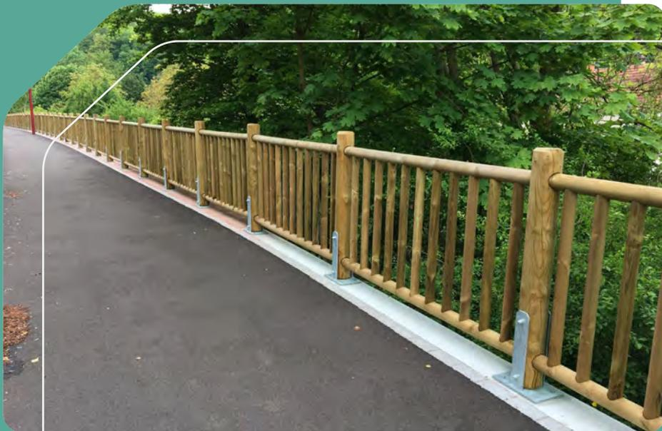
Exemple d'ancrage galvanisé à chaud
