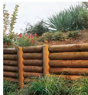
**Le mur de soutènement** est un mur vertical qui permet de contenir de la terre ou du remblai sur une surface réduite.
