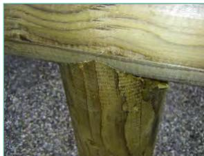
Jonction esthétique entre le support et la lisse par l'usinage « gueule de loup »
