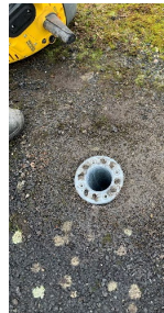
Etape 5 : vérification intermédiaire de la rectitude du pieux dans le sol
