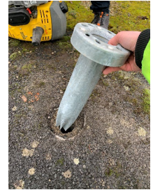
Etape 4 : insertion du pieux d'ancrage dans le sol
