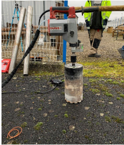
Etape 1 : délimitation par empreinte ou carottage de la zone d'implantation
