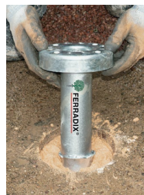
Pieux d'ancrage CITY Adjonction de 20 % de béton
