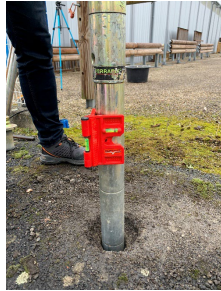
Etape 2 : fonçage du trou dans le sol – vérification de l'alignement axial
