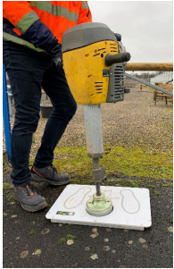
Etape 1 : délimitation par empreinte ou carottage de la zone d'implantation
