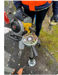
Etape 4 : insertion du pieux d'ancrage dans le sol
