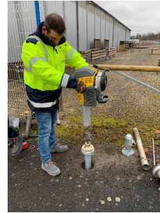
Etape 3 : fonçage du pieux d'ancrage par marteau pneumatique et outil de pose dédié.
