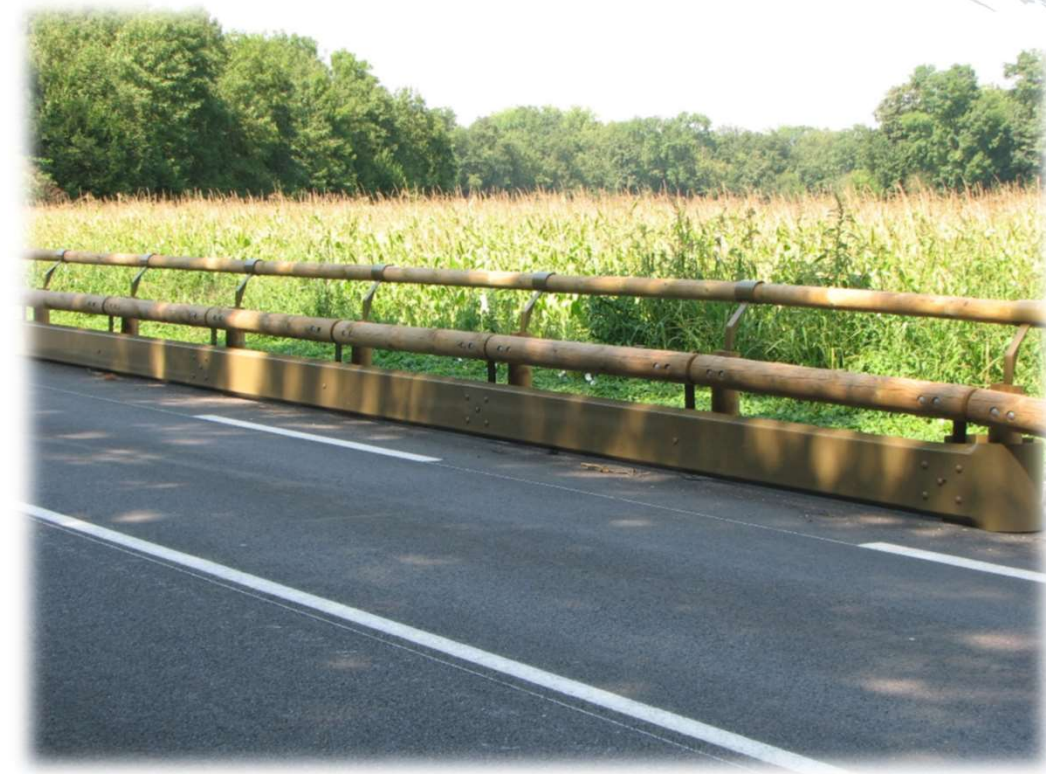
SOLOBOIS avec réhausse main courante et écran de protection motards.
