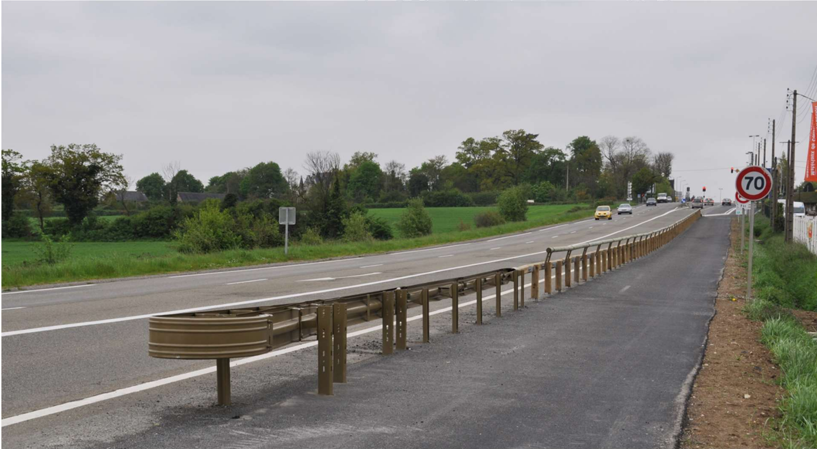
Extrémité de file performante raccordée sur glissière SOLOBOIS
