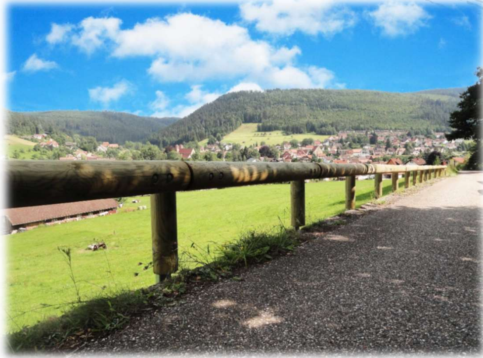
Chemin communal avec support décentralisés sur muret - Allemagne
