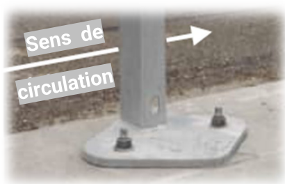
Support sur platine à 2 points d'ancrage
