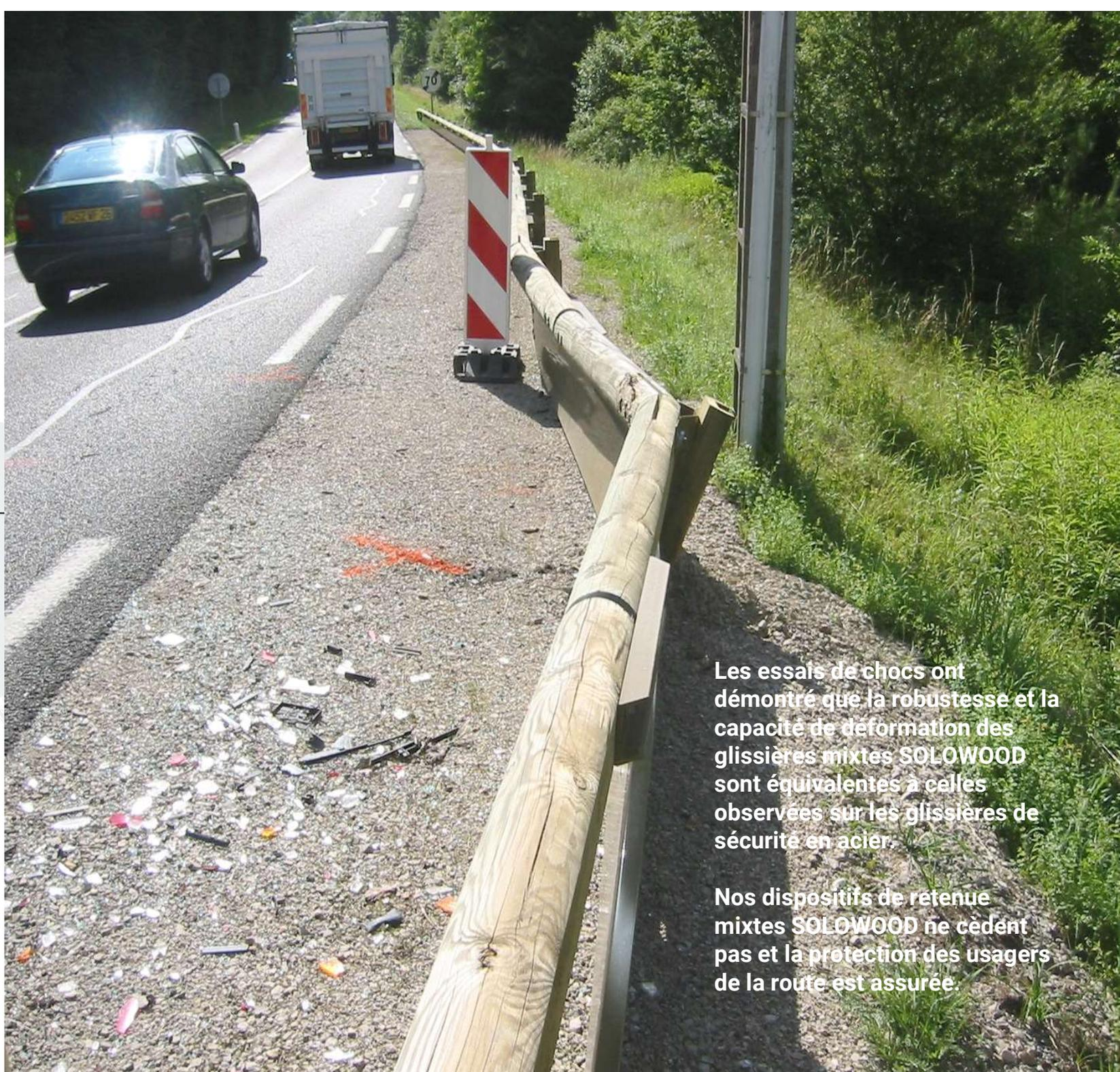
Les essais de chocs ont démontré que la robustesse et la capacité de déformation des glissières mixtes SOLOWOOD sont équivalentes à celles observées sur les glissières de sécurité en acier.
