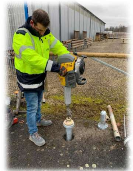
Etape 3 : fonçage du pieux d'ancrage par marteau pneumatique et outil de pose dédié.
