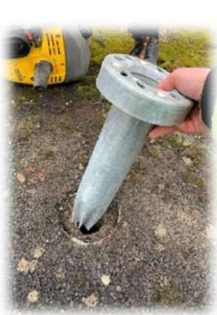
Etape 4 : insertion du pieux d'ancrage dans le sol
